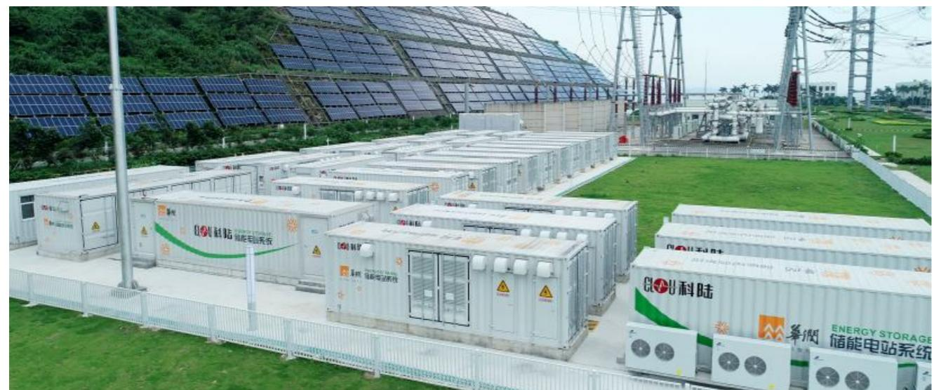
科陆 - 华润电力（小漠电厂）30MW储能辅助调频项目，总规模为30MW/14.93 Mwh，由深圳市科陆电子科技股份有限公司提供设备与技术，建设时间为2018年8月份，主要参与广东调频辅助服务市场。
